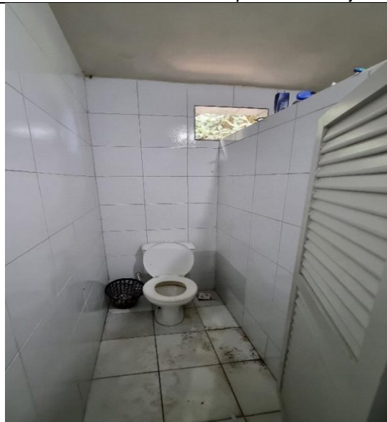
Limpeza precária no banheiro do Bloco F do campus II
