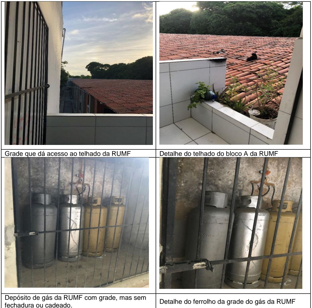
Imagem 12 - Acesso ao telhado e depósito dos cilindros de gás
