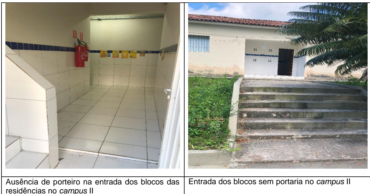
Imagem 02 - Ausência de Portaria na entrada dos Blocos
