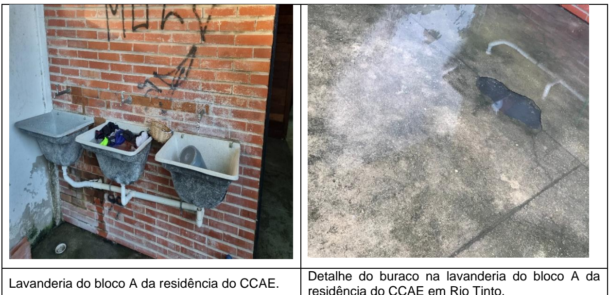
Imagem 21 - Acúmulo de água no piso da área de serviço e da lavanderia
