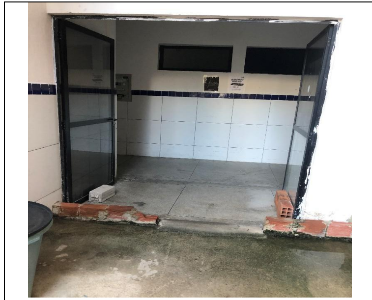
Detalhe da barreira de tijolos na entrada do anexo B da RUMF
