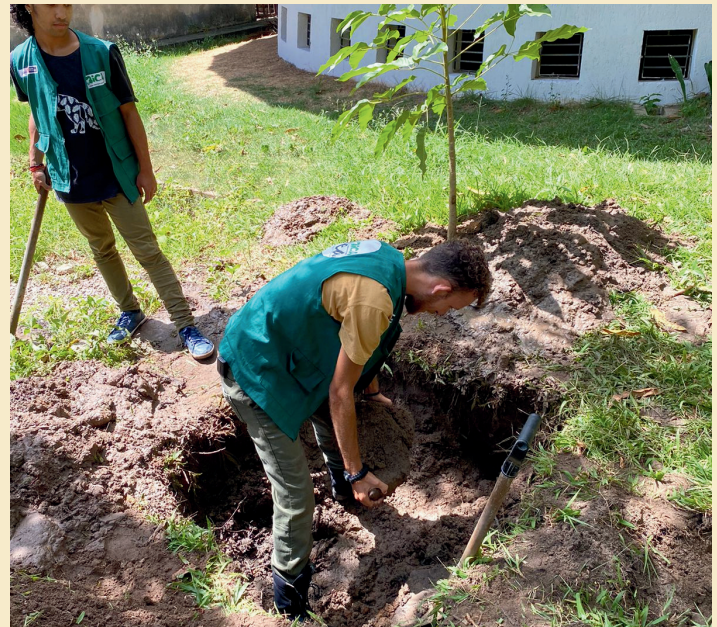
Passo 1 : Escavação do buraco
