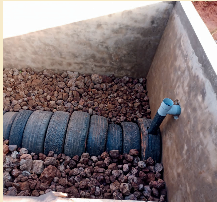
Passo 4 : Disposição de material grosseiro
