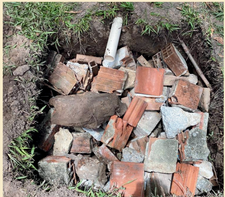
Passo 2 : Instalação do tubo de 50 mm
