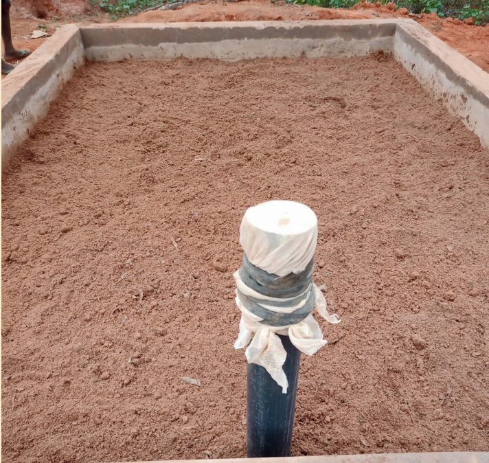
PASSO 7 : Camada de terra fértil.
