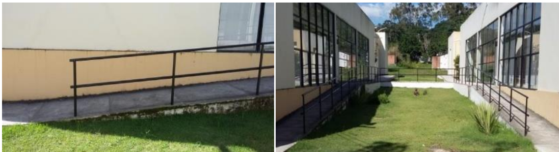
Figura 4. Rampa de acessibilidade no prédio da Biologia
