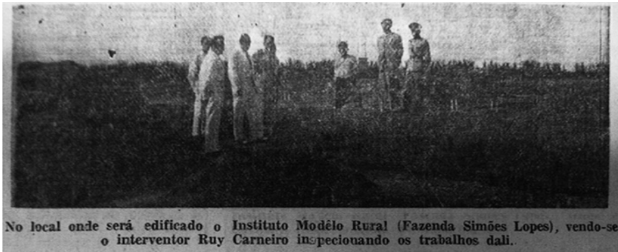
Imagem 15: Interventor inspecionado o local de construção do Instituto Modelo Rural
