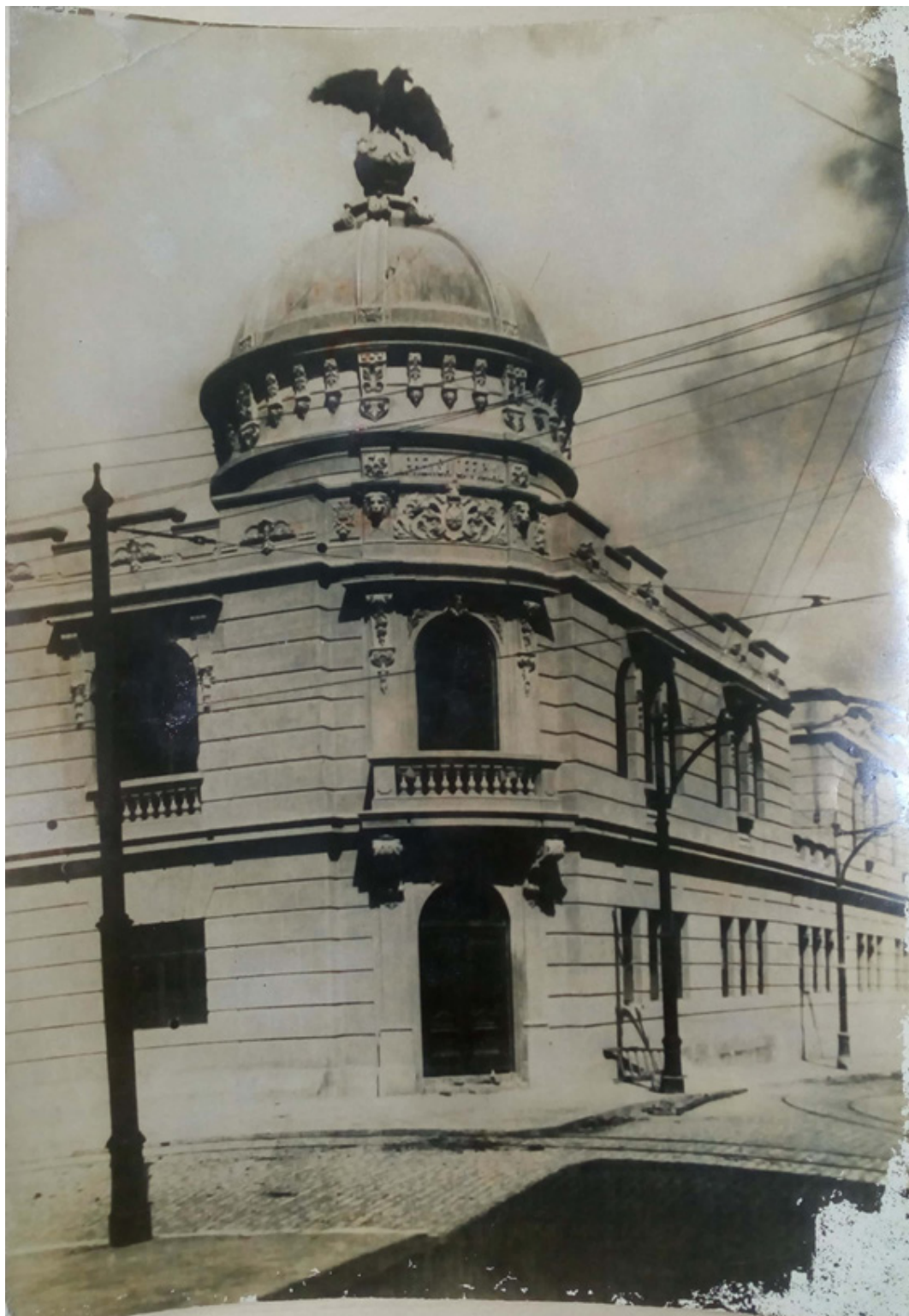
Foto 9 – Fachada lateral do antigo prédio do jornal A União, na Praça João Pessoa, demolido para a construção da atual sede da Assembleia Legislativa. Fotografia do acervo particular do jornalista Hélio Zenaide, cedida à CMV pela sua família.
