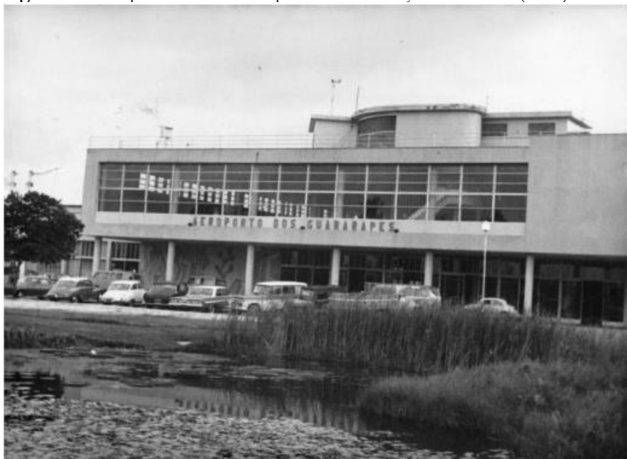
Figura 8 - Aeroporto dos Guararapes Gilberto Freyre em Recife (1958).
