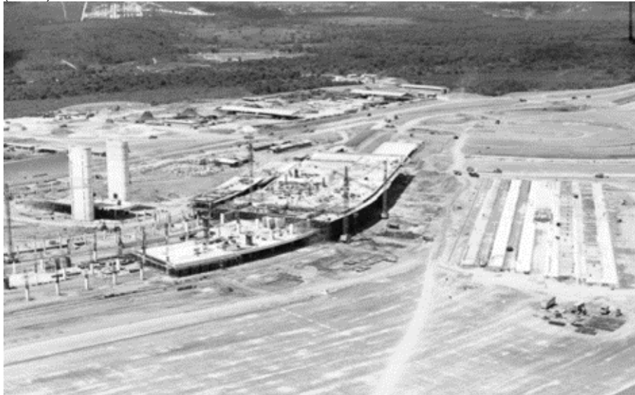
Figura 12 – Construção do Terminal do Aeroporto Internacional de Confins (1984).
