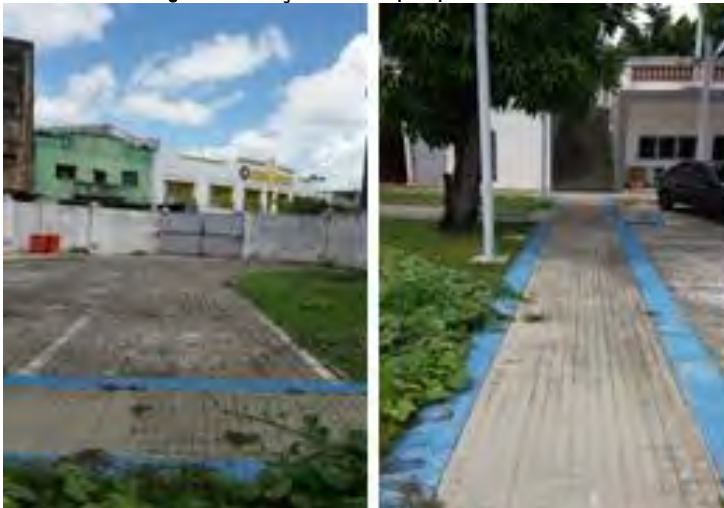
Figura 12 – Calçada e acesso pelo portão dos fundos
