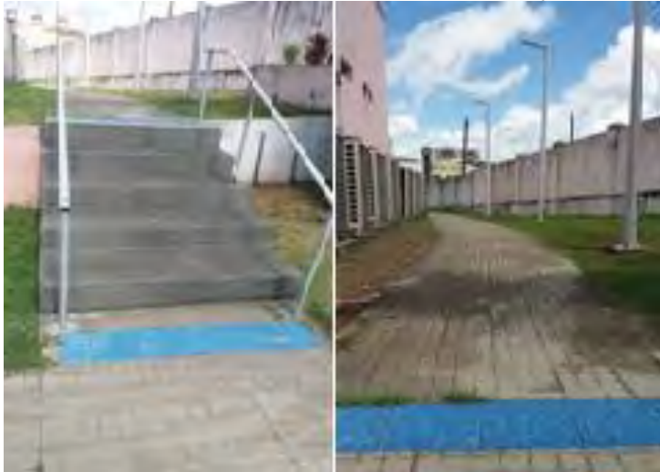
Figura 11 – Acesso lateral ao estacionamento, escada e calçada
