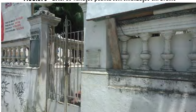
FIGURA 6 - Local de visitação pública sem sinalização em Braille
