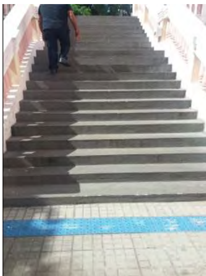
Figura 9 - Escada de Acesso a Administração
