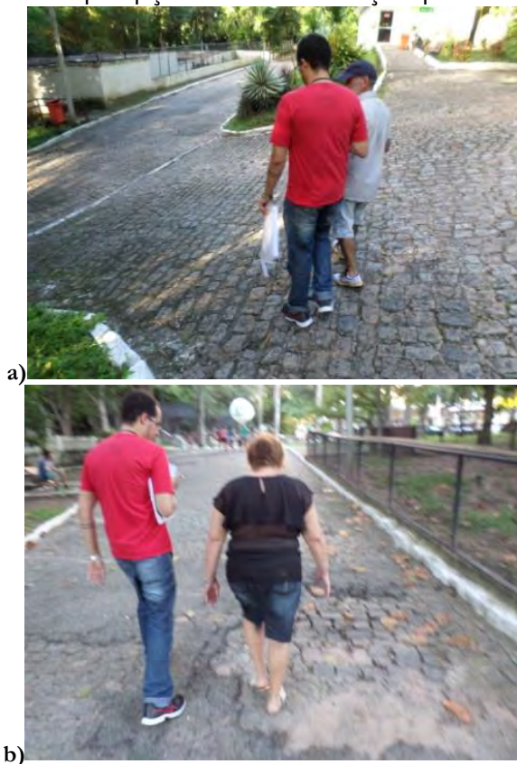
Figura 04: a) Sujeito 2 descendo em área de declive. b) Sujeito 03 relata preocupação com o estado de conservação de parte da via de passeio.
