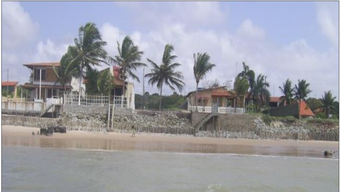
Figura 20 – Indicadores de erosão costeira na praia do Seixas, evidenciados com a construção de espigões permeáveis feitos com manilha, muro em concreto em frente às residências, protegido por anteparo de rocha calcária seguido de estaqueamento em madeira. Foto: Cláudia S. V. Silva, em janeiro de 2009.
