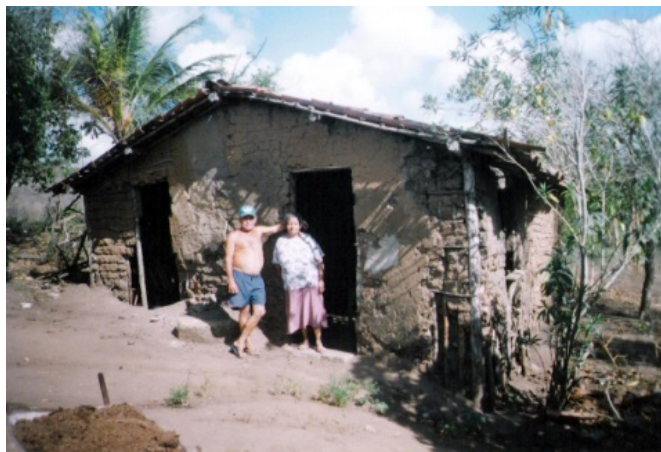
Figura 09: Casa de taipa construída na parcela de Dona Neura após a desapropriação da terra no aguardo do financiamento das residências. Arquivo Di Lorenzo. Pesquisa Direta, Maio de 2006.
