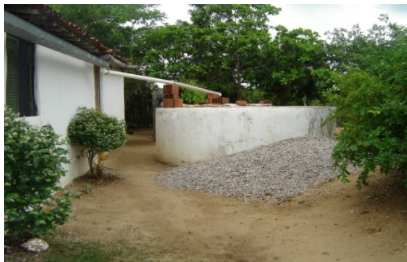
Figura 38 - Cisterna de Placas construída na parcela do Seu Antônio Severo. Fonte: Arquivo Di Lorenzo. Pesquisa Direta, novembro de 2005.
