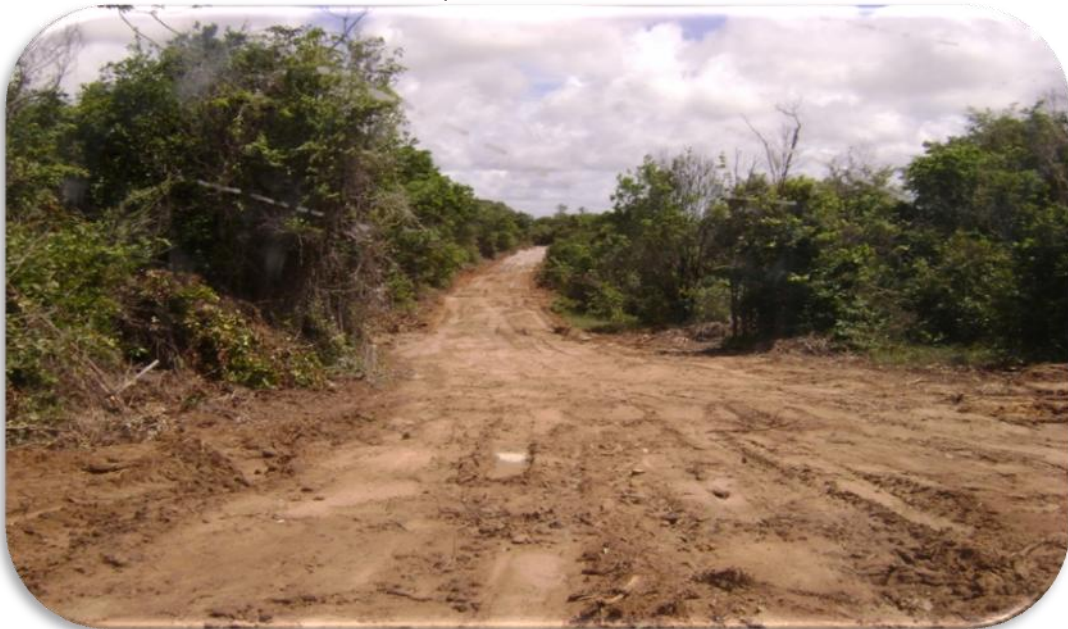
Ilustração 96. Abertura de Picada nas proximidades da praia de Coqueirinho para instalação de equipamentos urbanos que subsidiarão os loteamentos.
