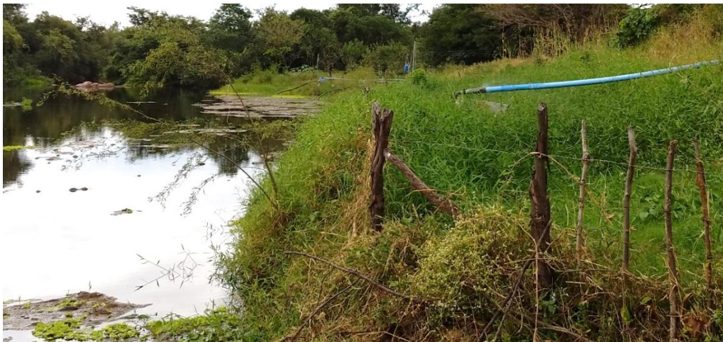
Figura 18. Ligações clandestinas de água às margens do Rio Piranhas
