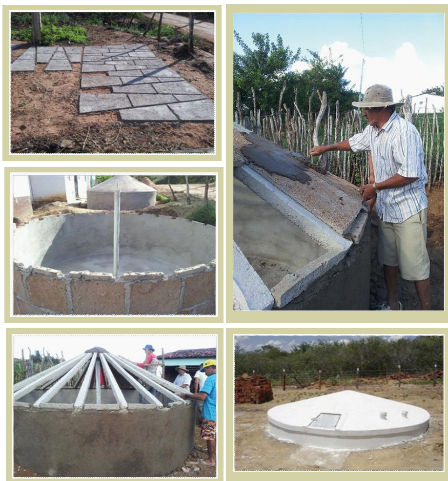
PHOTO 4- CONSTRUCTION DES CITERNES A PLAQUES DE BETON -16 000 LITRES
