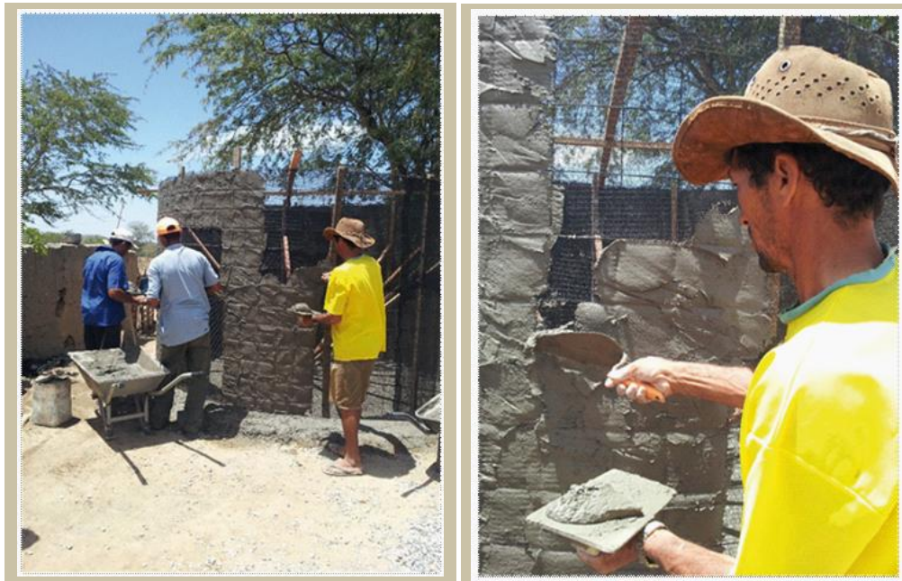
PHOTO 5 - CONSTRUCTION DE CITERNE A TREILLIS METALLIQUE -16 000 LITRES
