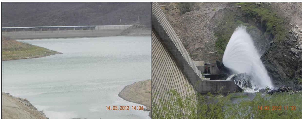
Figura 84 – Barragem/açude de Acauã e comporta de descarga (Franklyn e Wilton Velez 14/03/2012)
