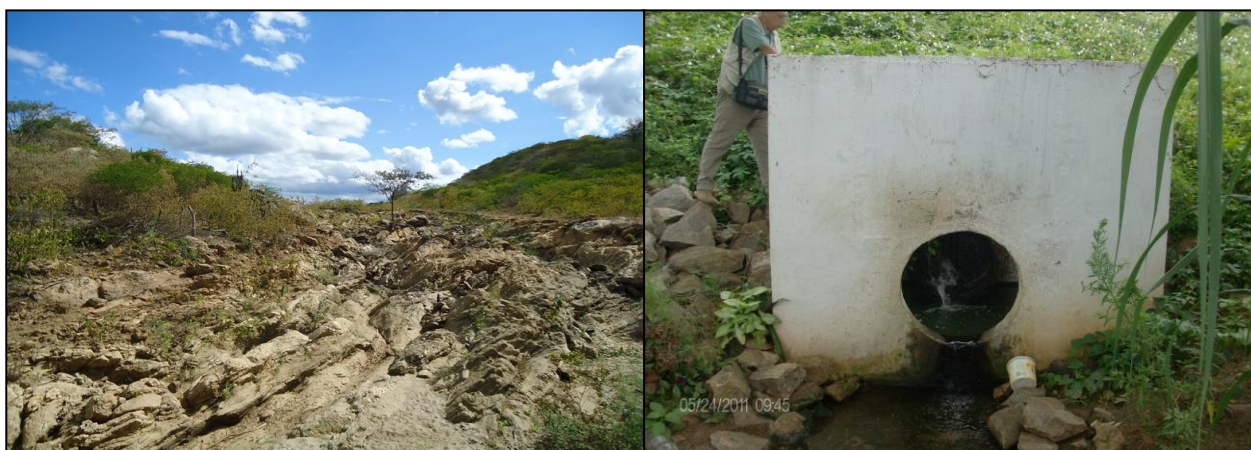
Figura 4 – Sangradouro e comporta de descarga do açude Poções desativada desde 1994 (Franklyn 24/05/2011)
