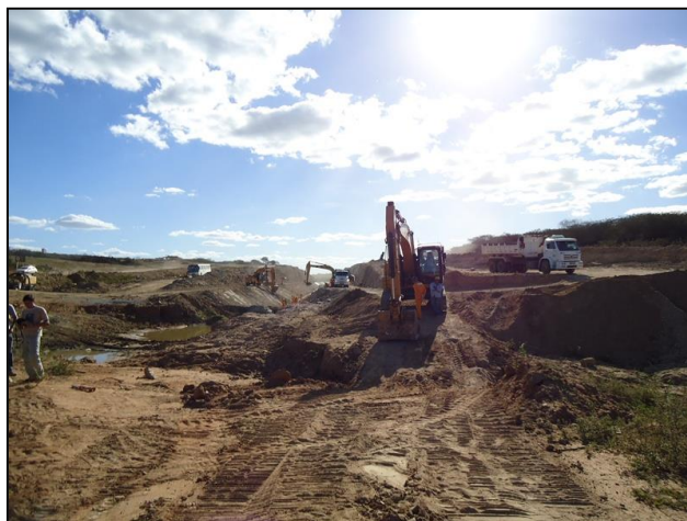
Figura 35 – Uso das máquinas na construção do Eixo Leste do PISF (Franklyn, 26/08/2010)
