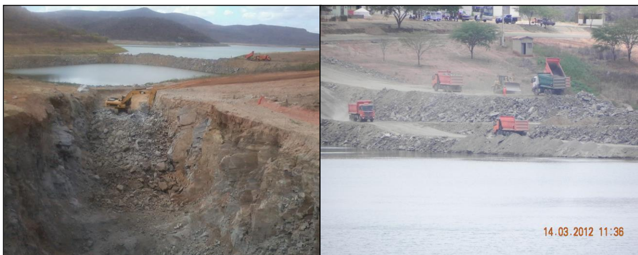
Figura 60 – Canteiro de obras do Canal da Vertente Litorânea –Itatuba-PB (Franklyn 14/03-2013)
