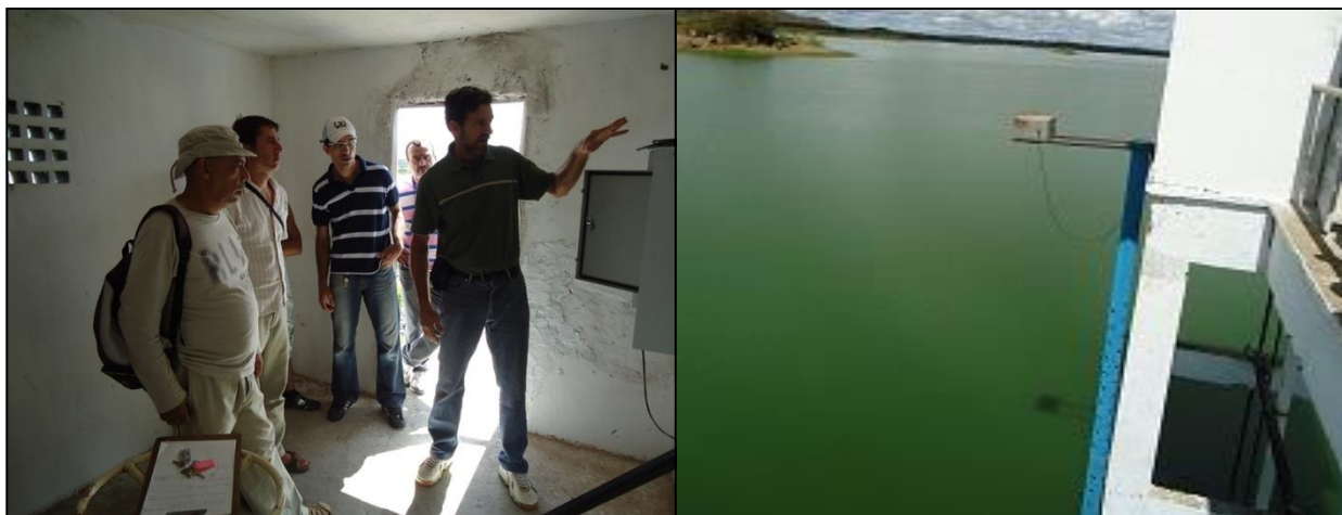
Figura 3 – PCD instalada no açude Poções, município de Monteiro – PB (Diego Oliveira 27/08/2010)
