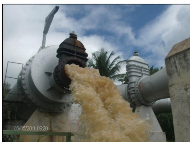
Figura 12: Comporta de descarga do açude Epitácio Pessoa aberta (Franklyn 05/05/2011)
