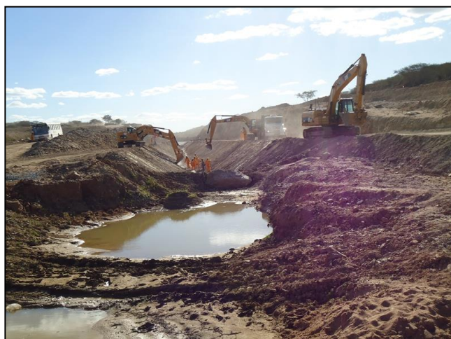
Figura 24 – Lote PISF 12 em construção – Eixo Leste, município de Sertânia (PE) em direção a bacia hidrográfica do rio Paraíba – PB (Franklyn, 26/08/2010)
