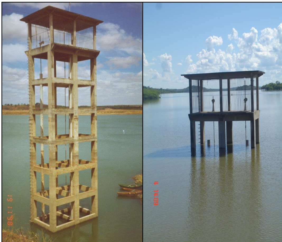
Figura 53 – Torre de tomada d’água (AESA, 1998)
