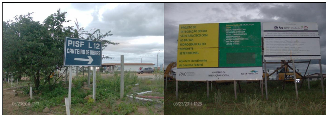
Figura 6 – Canteiro de obras do PISF/Lote 12, Município de Sertânia – PE (Franklyn 23/05/2011).
