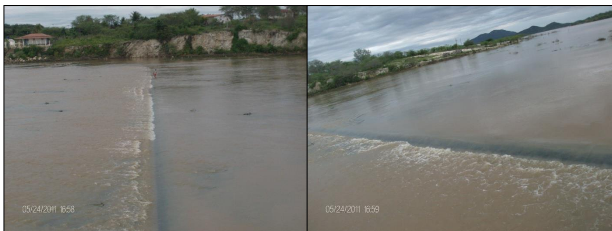
Figura 11: Cinta de concreto a partir da qual considera-se o açude vertendo/sangrando (Franklyn 24/05/2011).
