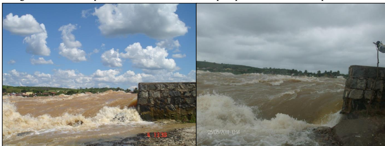
Figura13 –Vazão no vertedouro do açude Epitácio Pessoa (Franklyn 04/04/2008) Figura14 – Vazão no vertedouro do açude Epitácio Pessoa (Franklyn 05/05/2011)
