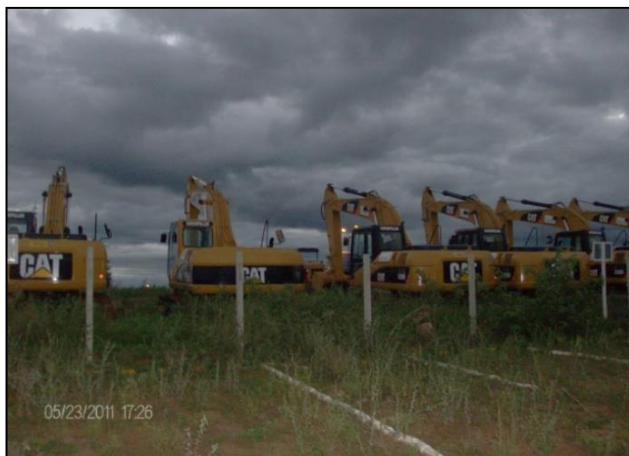
Figura 7 – Máquinas estacionadas no pátio do canteiro de obras do Lote 12 do PISF (Franklyn 23/05/2011)
