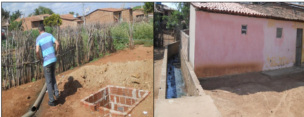
Figura 83 – Fossa séptica sendo construída para substituir os lançamento de dejetos diretamente a “céu aberto” e canal de esgoto, cuja “foz” é o açude Epitácio Pessoa – Comunidade rural de Floresta (Franklyn 18/12/2011).
