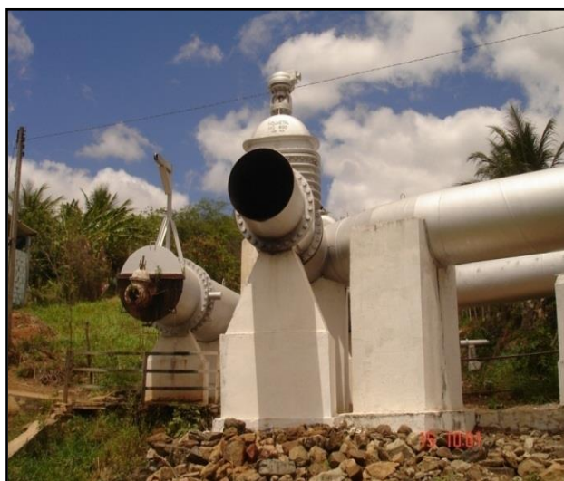
Figura 55 – Comporta de descarga desativada (Franklyn 15/06/2011)
