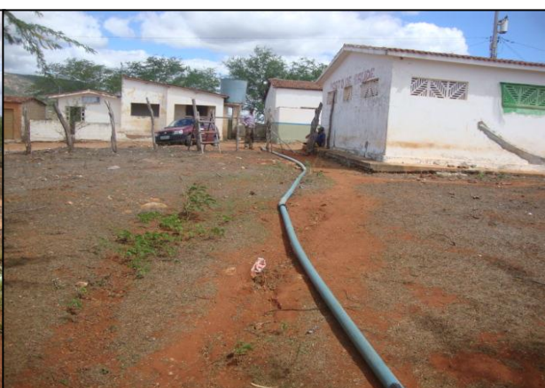
Figura 82 – Cano de 100 mm usado para o abastecimento de água do Mirador (Franklyn 26/05/2012)
