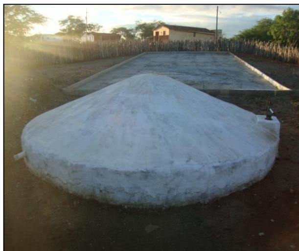
Figura 26 – Cisterna calçadão na comunidade rural de Bento – Boqueirão-PB (Franklyn 01/08/2012)
