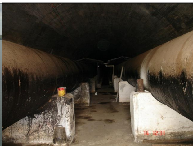
Figura 45 – Túnel de saída das adutoras da torre (Franklyn 03/01/2011)
