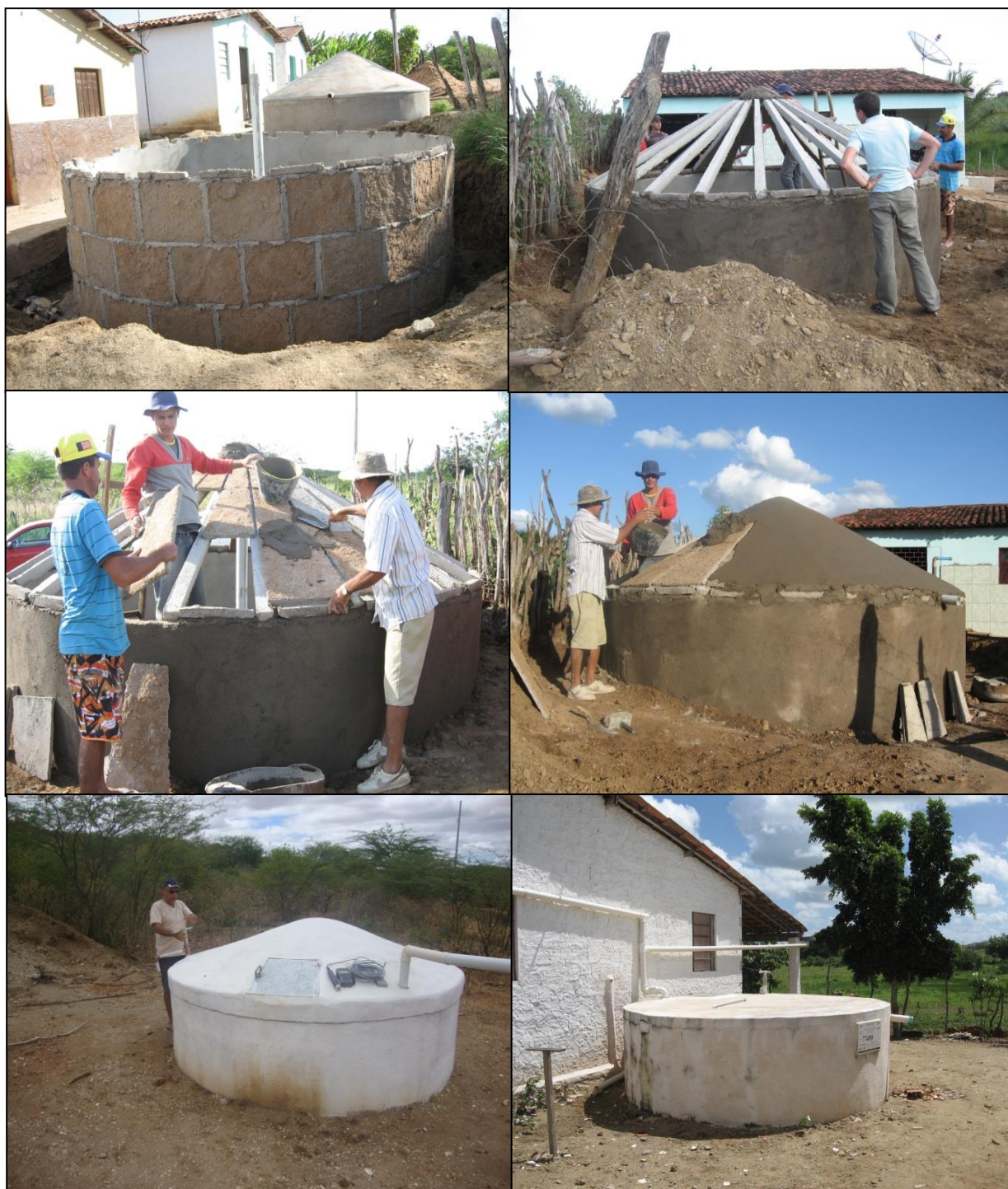
Figura 25 – Etapas de construção da cisterna de placa para 16 mil litros – comunidade rural de Bredos – Boqueirão-PB. *A última imagem é de uma cisterna construída nos mesmos moldes, porém, com telhado horizontal e não cônico. (Franklyn 01/08/2012).
