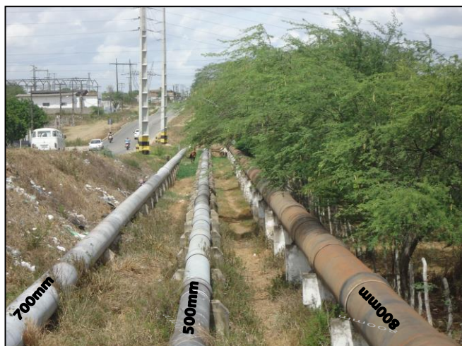
Figura 49 – Adutoras que partem da ETA de Gravatá chegando a Campina Grande – Alça Sudoeste com Av. Juscelino Kubitschek (Franklyn 05-01-2013)
