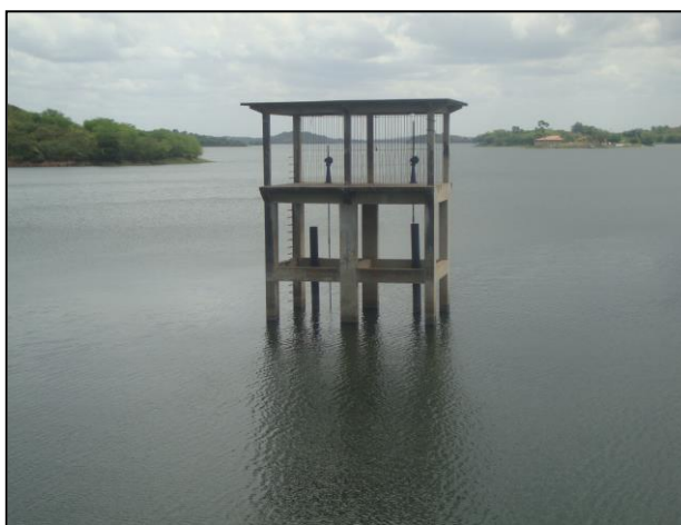
Figura 44 – Torre de tomada d' água açude Boqueirão (Franklyn 27/03/2011)
