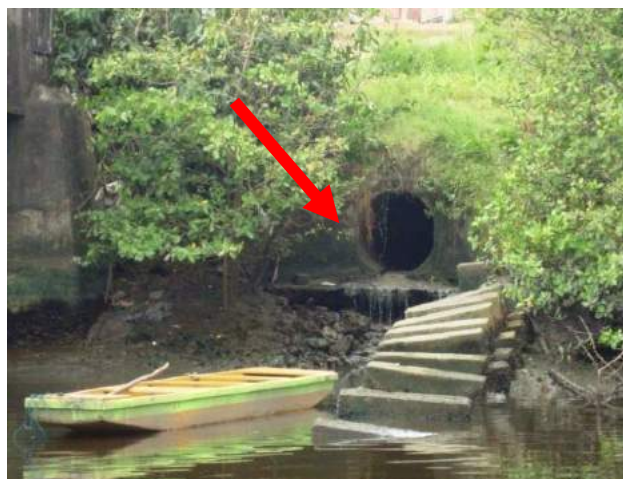
Figura 9 – Galeria de água pluvial
