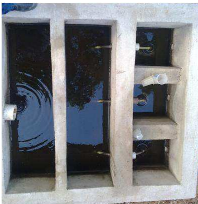
Figura 3 – Caixa separadora de vazão
