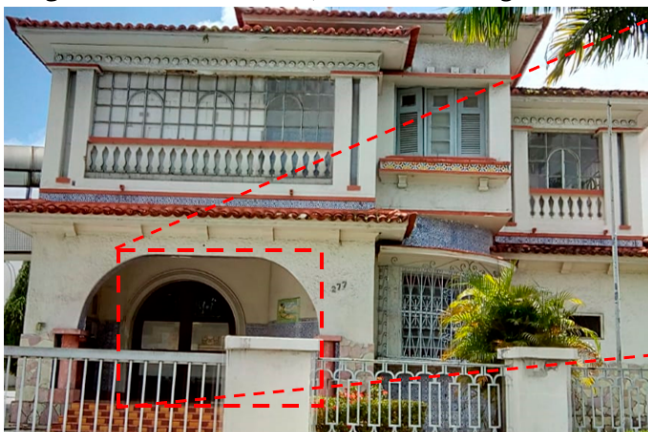
Figura 7 - Imóvel nº 277, Av. Getúlio Vargas.
