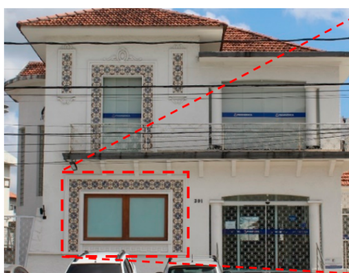
Figura 13 - Imóvel nº 301, Av. Getúlio Vargas.
